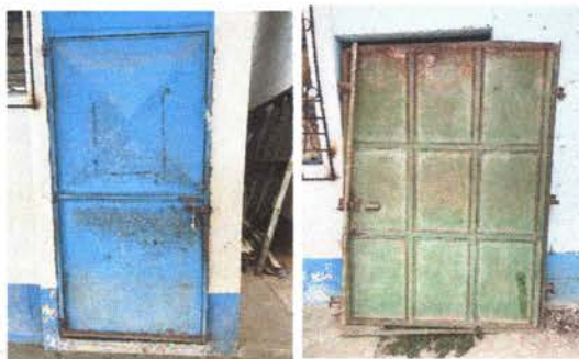
Foto 2 Sustitución de chapa y puertas
