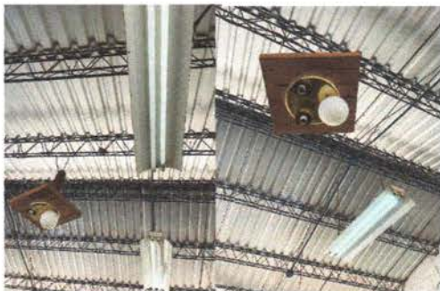
Foto 1 sustitución de focos ahorradores
