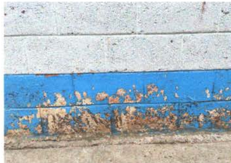
Foto 4 Pintura en muro exterior
