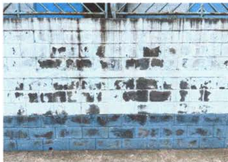
foto 3 pintura en muro interior y exterior
